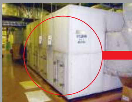
AHU 内交換前のフィルター（カビが発生）
