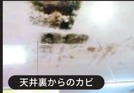
保温材の厚みが足りずに表面結露が発生
