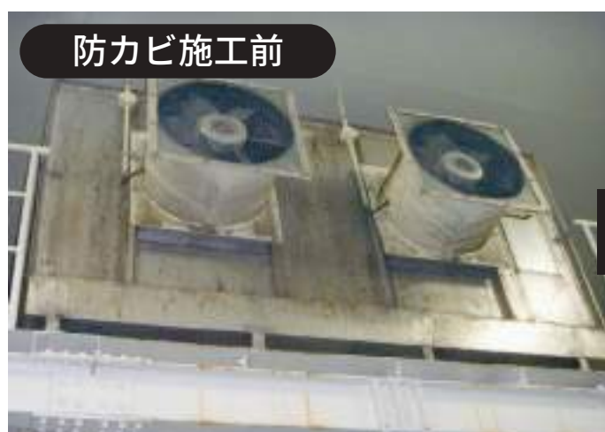
①熱交換器を守護神（除菌消臭剤）で高圧洗浄
