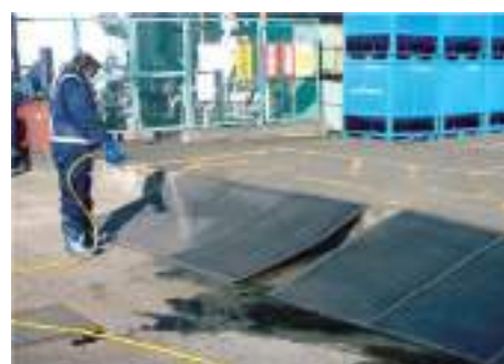
<施工前清掃>フィルター清掃
