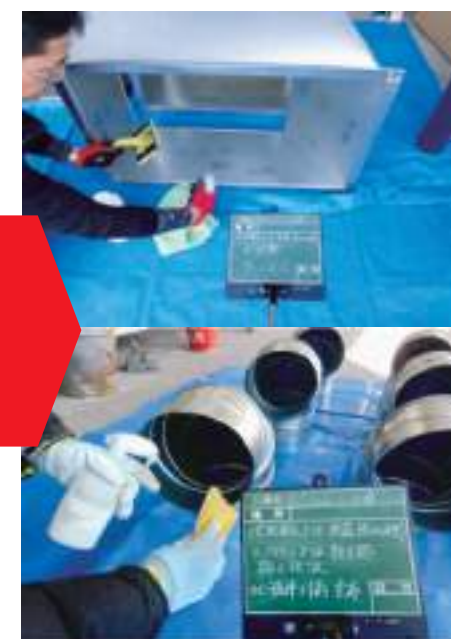
②カビ守護神（コーティング剤）を表面に塗り広げ防カビコート
