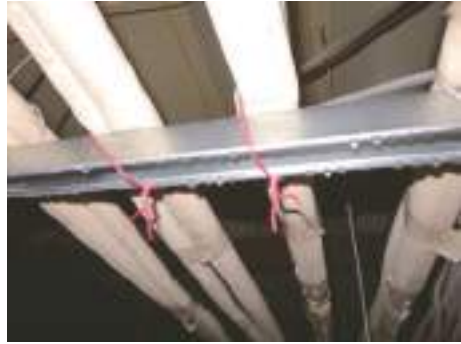
保温材の厚みが足りずに表面結露が発生
