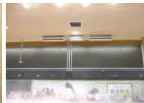
②断熱シートで強化、カビ守護神（コーティング剤）でコート
