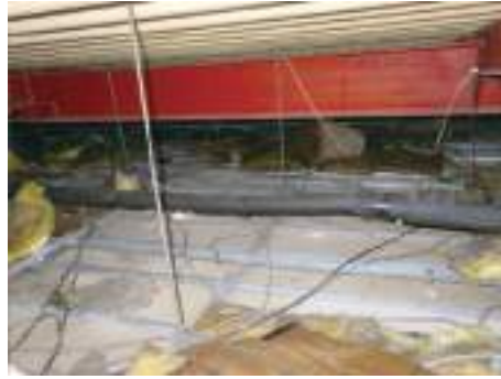
配管設備機器の結露や配管ダクトからの漏れ / 破損
