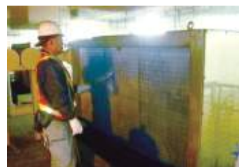
<施工前清掃>熱交換器を高圧洗浄
