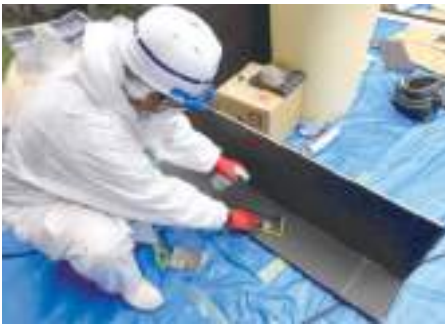
③ 各パーツを除菌洗浄後、カビ守護神（コーティング剤）でコート、または施工用を噴霧
