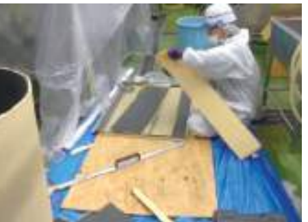
② 飛散しない独立発泡型の断熱シートに張り替える
