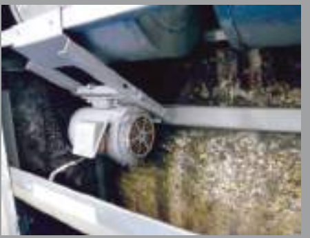
パネルを分解（内部に多くのカビが発生）
