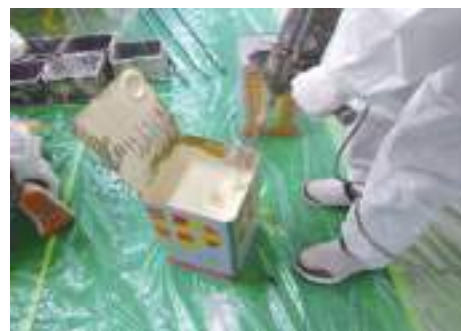
②攪拌器でよく混ぜる
