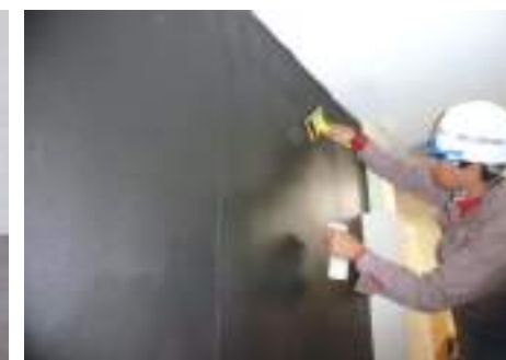
③断熱パネル施工後、カビ守護神（コーティング剤）でコート
