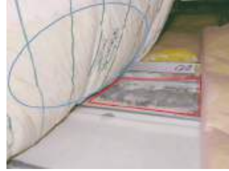
断熱材が水分を含み天井ボードにカビが発生
