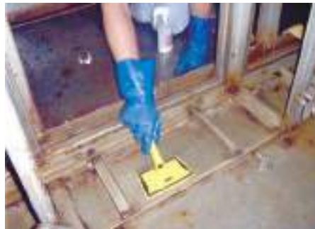
③ カビ守護神（コーティング剤）を表面に塗り広げ防カビコート
