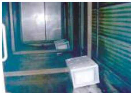
④ 置き型除菌剤【守護神ゲル】（4L/ 施工用業務サイズ）を設置
