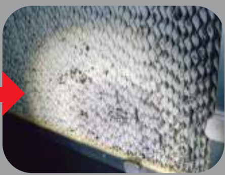
AHU 内交換前のフィルター（カビが発生）
