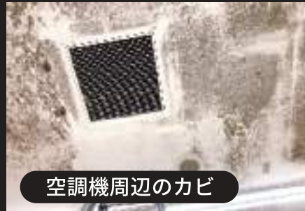
断熱材が水分を含み天井ボードにカビが発生
