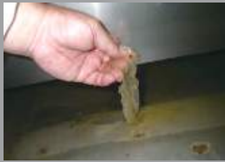
水漏れが発生し調査⇒ドレン配管 / Cトラップ内のスライム発生で詰まり
