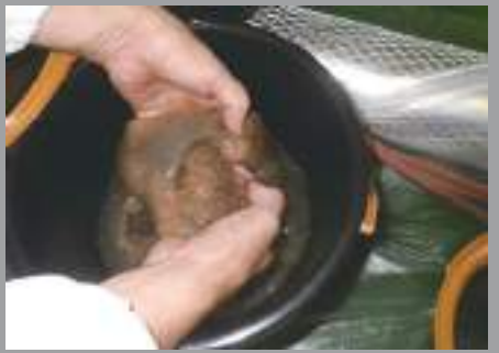
水漏れが発生し調査⇒ドレン配管 / Cトラップ内のスライム発生で詰まり
