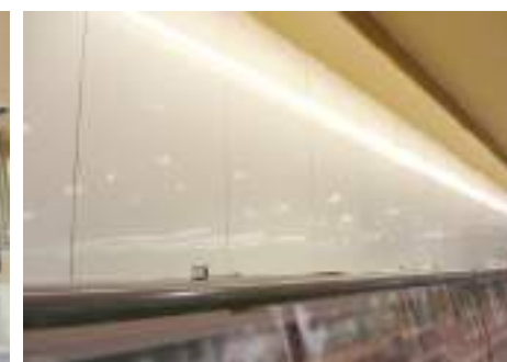
③仕上げパネルで施工完了
