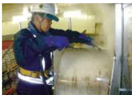
<施工前清掃>カビ除去
