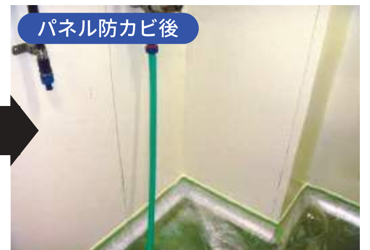
②防カビシーリング剤で継ぎ目に打ち込む
