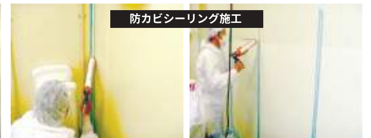
②防カビシーリング剤で継ぎ目に打ち込む
