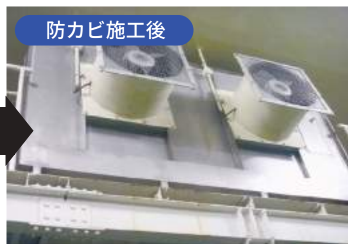
②熱交換器にカビ守護神（施工用）を吹き付け防カビ処理
