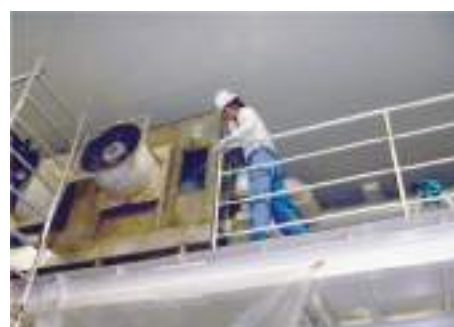
②熱交換器にカビ守護神（施工用）を吹き付け防カビ処理
