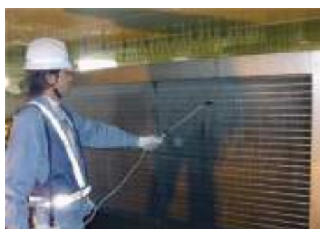
①熱交換器を守護神（除菌消臭剤）で高圧洗浄
