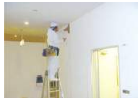
③その糊を使用しクロス貼り
