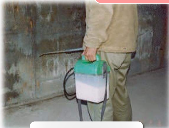
コンクリート壁
