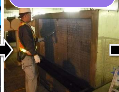
③熱交換器高圧洗浄
