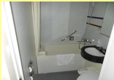
■施工するユニットバス
