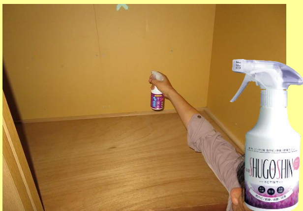
カビ守護神を噴霧し乾燥させ防カビ処理。
