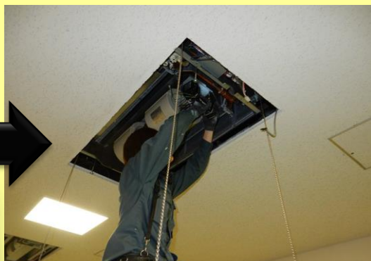
乾燥後、各パーツ取り付け
