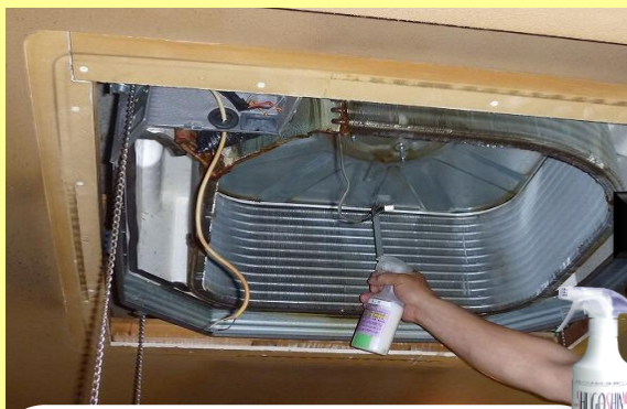
熱交換器にカビ守護神 吹き付け
