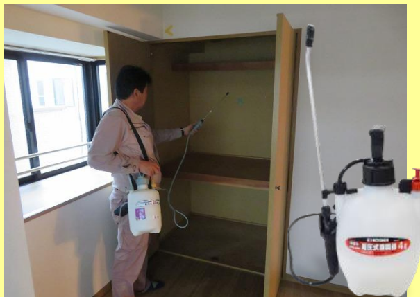
噴霧器を使用。全体的にカビ守護神を噴霧し、よく乾燥させる。
