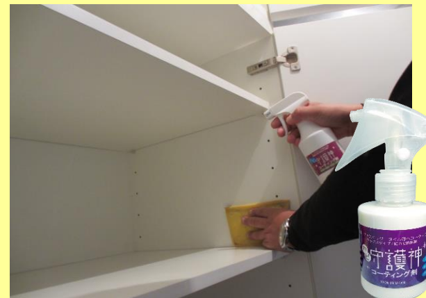
浸透性のない場所はカビ守護神コーティング剤を使用し、コテバケで薄く伸ばして乾燥させる。
