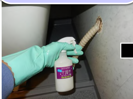
エプロン内部 壁面・床面 カビ守護神コーティング剤塗布
