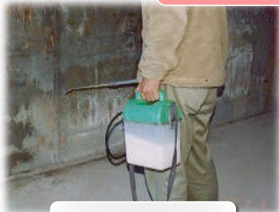
コンクリート壁
