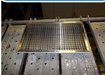
充填室吹き出し口 器具
