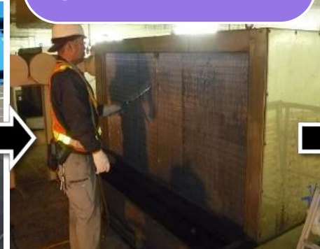
③熱交換器高圧洗浄
