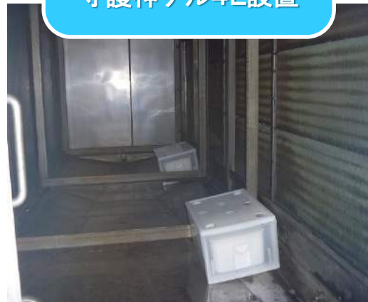
守護神ゲル4L設置
