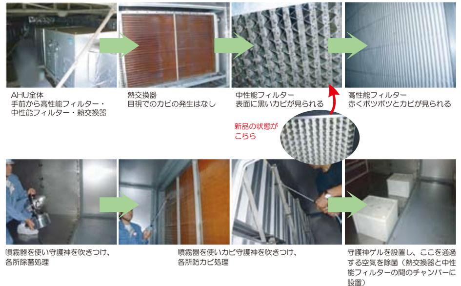
AHU全体 手前から高性能フィルター・中性性能フィルター・熱交換器
