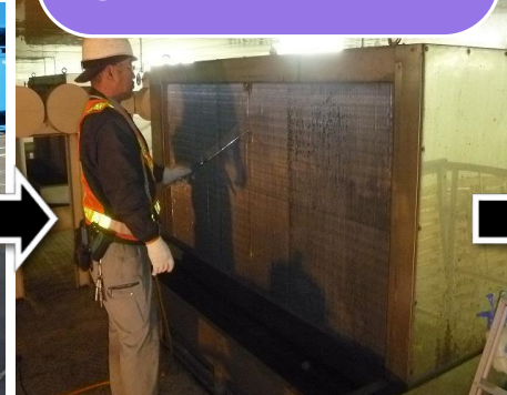
③熱交換器高圧洗浄
