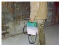
コンクリート壁
