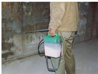
コンクリート壁
