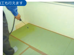
畳への防カビ施工
