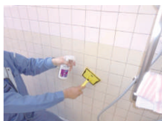
浴室タイルに防カビコート
