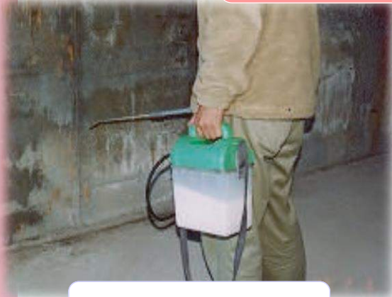
コンクリート壁
