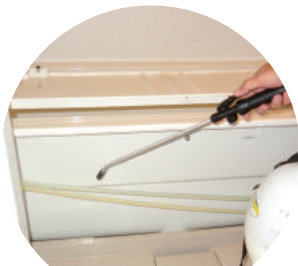
浴槽のパネル内側
