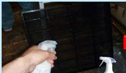
洗浄したドレンパン・フィルターにカビ守護神を噴霧し、 スライム・ぬめり防止に
