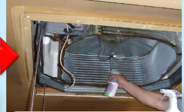
熱交換器にカビ守護神 吹き付け
