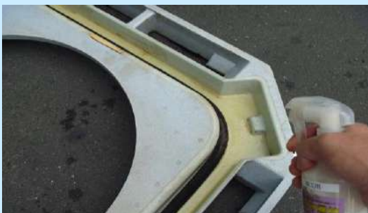
洗浄したドレンパン・フィルターにカビ守護神を噴霧し、 スライム・ぬめり防止に
