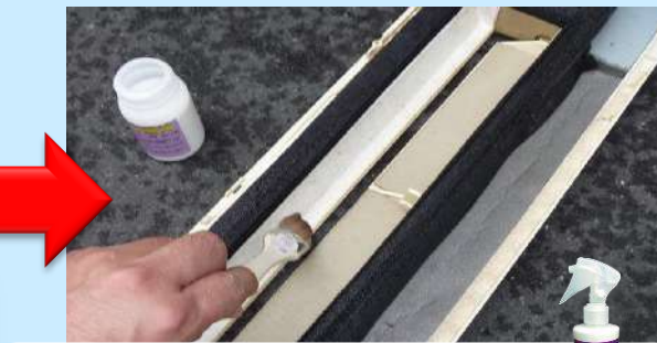
フラップ内側を カビ守護神コーティング剤で防カビ処理
