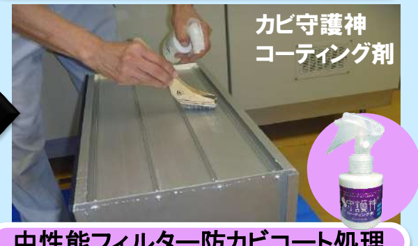
中性能フィルター防カビコート処理
