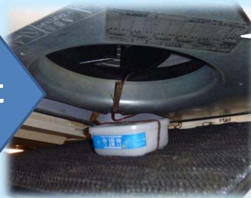
熱交換器に守護神 吹き付け
