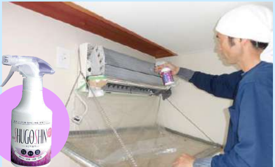
カビ守護神を吹き付け防カビ処理
