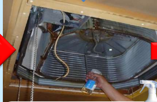
熱交換器に守護神 吹き付け
