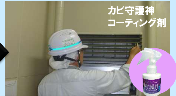
吹き出しフラップ防カビコート処理
