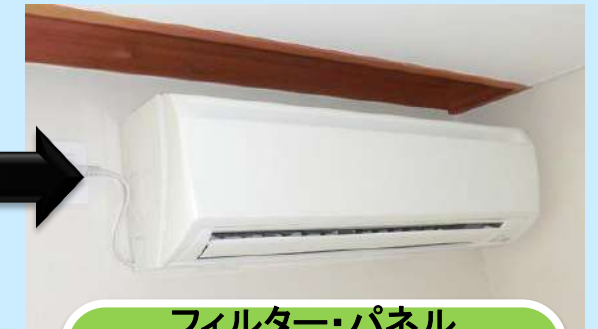
フィルター・パネル ルーバーを取付け
